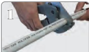
Cortar en ángulo recto la sección de tubo. El corte se realiza fácilmente usando una tijera cortatubos.
