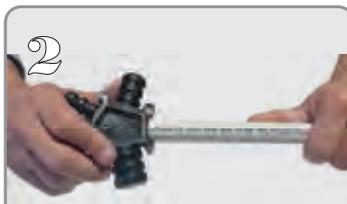
Calibrar y biselar el extremo del tubo cortado. Girando el biselador Ferco. Se debe comprobar que tanto el interior como el exterior del tubo se han biselado correctamente.
