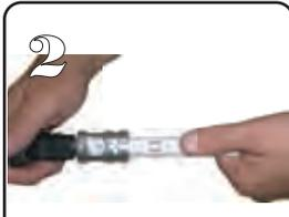
Calibrar y biselar el extremo del tubo cortado. Comprobar visualmente la calibración. Engrasar tubo y pieza.
