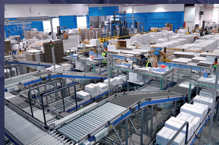
NUEVO CENTRO LOGÍSTICO NEW LOGISTIC CENTER
