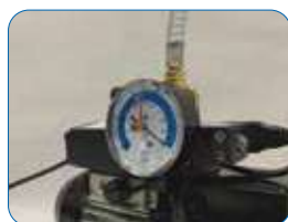
Conexión con bomba de vacío
