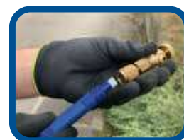
Colocación de nueva junta
