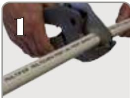
Cortar en ángulo recto la sección de tubo. En caso de usar tubería multicapa es obligatorio calibrar y biselar.
